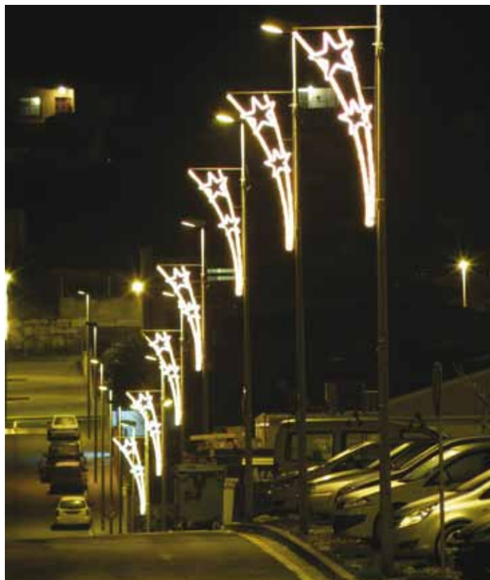
Secuencia de motivos instalados en farola. Puede montarse en horizontal. Seqüència de figures muntades a fanal. Pot muntar-se horitzontalment. Foto: Prov. de Madrid
