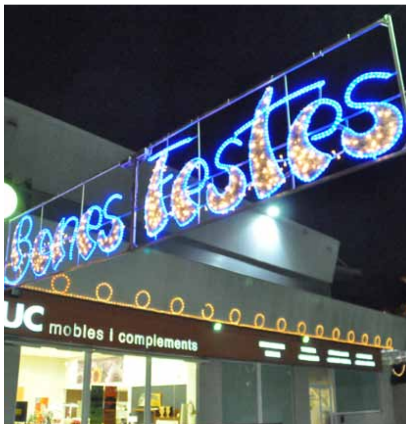
Montaje del rótulo en vertical sobre un panel de información Muntatge del rètol en vertical sobre un Plafó de informació Foto: Prov Lleida
