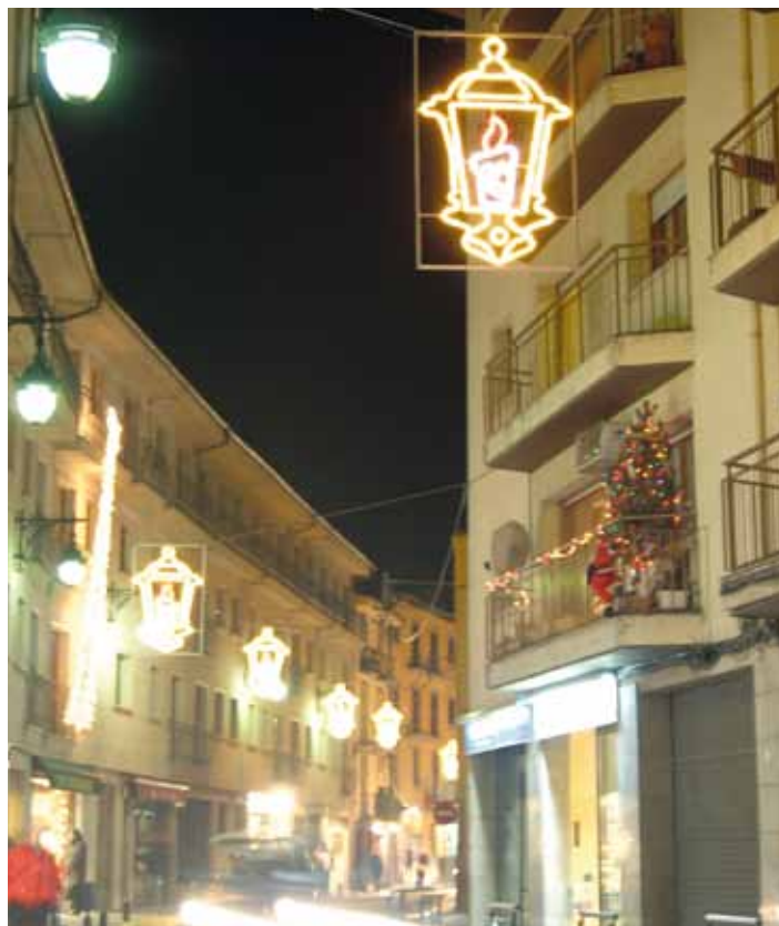
Montaje atirantado de faroles suspendidos en una calle de ancho medio Muntatge atirantat de fanals suspesos en un carrer d'amplada mitja Foto: Prov de Girona
